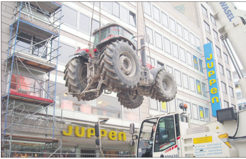
Der Stetter-Schlepper wurde über Gebäude durch einen Schacht gehievt.
